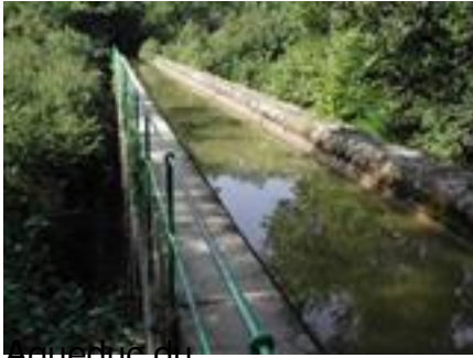
Aqueduc du Quiquengrogne (ou du Pré-Bourcier ), haut de 11,40 m, long de 76 m, et qui possède 12 arches,
